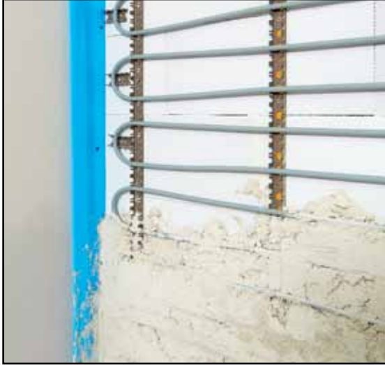
Укладка поверхностного отопления стен PRINETO мокрым способом
