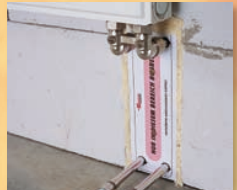
Соединительная труба 16U
