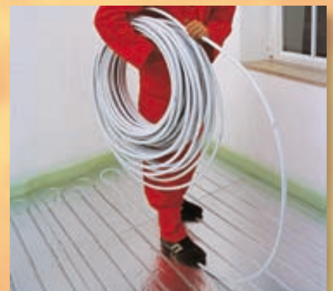
... и для сухой прокладки с теплопроводными элементами.
