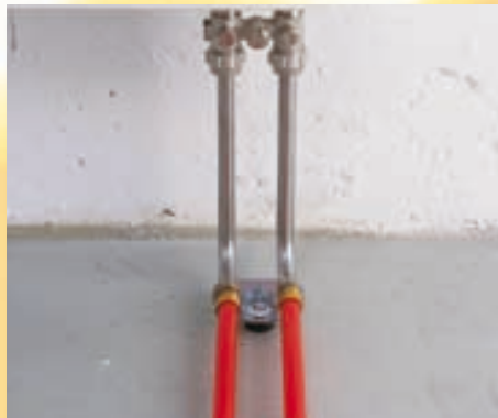
Скоба крепления PRINETO с изолирующей резиной, расстояние 50 мм.
