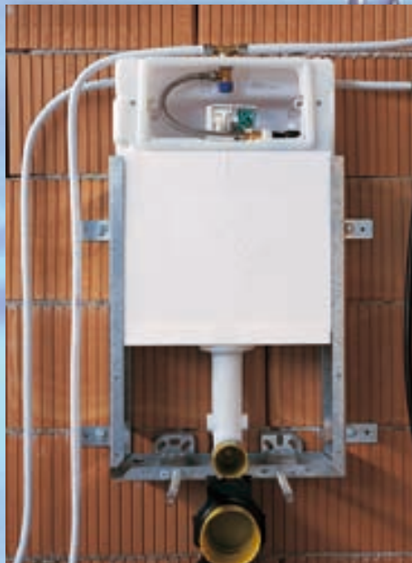
Скрытый сливной бачок PRINETO . Монтаж системы PRINETO .
