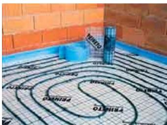
Система тёплых полов **PRINETO** основана на той же системе соединения, что и в области водоснабжения и отопления, и делает возможным укладку труб различными способами (наприм. скобами, фиксирующими шинами или на плиты с фиксаторами-бобышками), а также как мокрое или сухое устройство тёплых полов. Все виды системы тёплых полов **PRINETO** испытаны и сертифицированы по нормам DIN Certco. Система тёплых полов **PRINETO** может применяться в следующих областях: жилые и промышленные здания;
