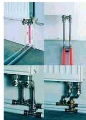
Система подключения отопительных приборов **PRINETO** - это дополнение к системе для водопровода и построена на основе тех же фитингов. Система делает возможным качественное, экономящее время и оптически превосходное подключение отопительных приборов в зданиях. **PRINETO** может применяться как для санирования уже существующих отопительных систем, так и для монтажа новых в старых (например система плintусной разводки) или новых зданиях с многочисленными вариантами подключения.
